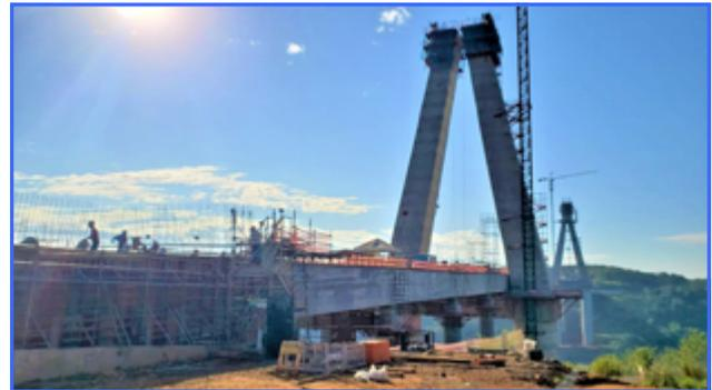
Em lado paraguaio, após a conclusão do deslocamento do conjunto: Aduela Metálica 5.1, Trechos Concretados 1, 2, 3 e 4, foi dada continuidade nas atividades da 2ª etapa da caixa de equilíbrio interna e preparação do encontro/acesso que interligará o nível do terreno ao tabuleiro da ponte. No mastro principal, sua 1ª fase de execução foi concluída, atingindo assim ao final do mês de junho, aproximadamente 64,5 metros de altura do tabuleiro ao topo da estrutura.
