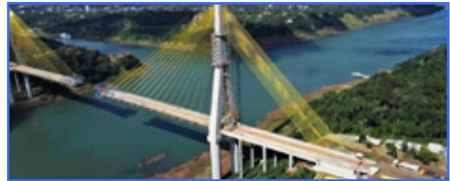
As pré-montagens das Aduelas Metálicas no canteiro de obras paraguaio continua em andamento com as unidades: 5.17 e 5.18. No Vão Central do tabuleiro continuam sendo executadas as armaduras dos guarda-rodas e bases do futuro guarda-corpo.
