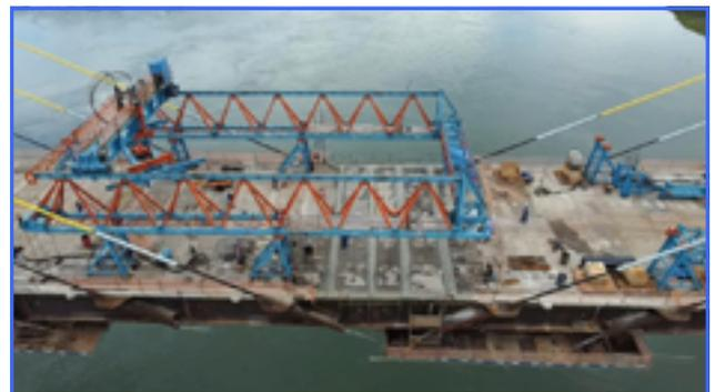
ocorreu o lançamento das lajes pré-moldadas sobre essas Aduelas e concretagem de interligação do tabuleiro tornando-o um único Vão Central da Ponte. Posteriormente, foram retomadas as execuções dos acabamentos como concretagem dos guarda-rodas do tipo *New Jersey* e bases do futuro guarda-corpo da Ponte.
