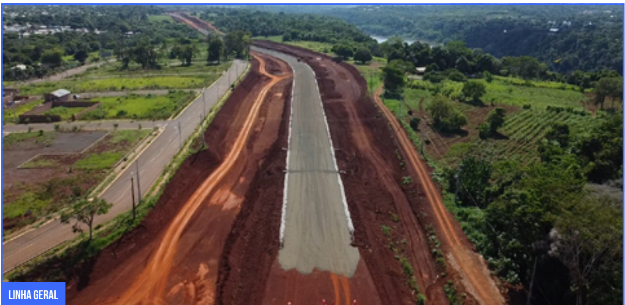
VIADUTO TANCREDO NEVES
