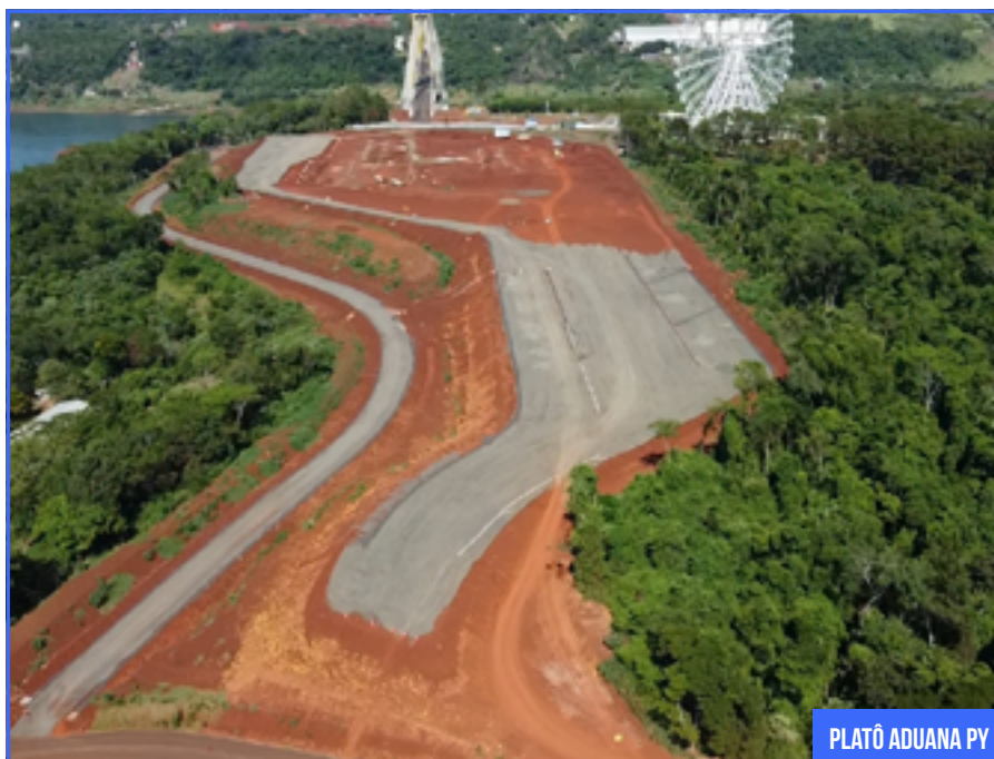
PILARES VIADUTO BR-277
