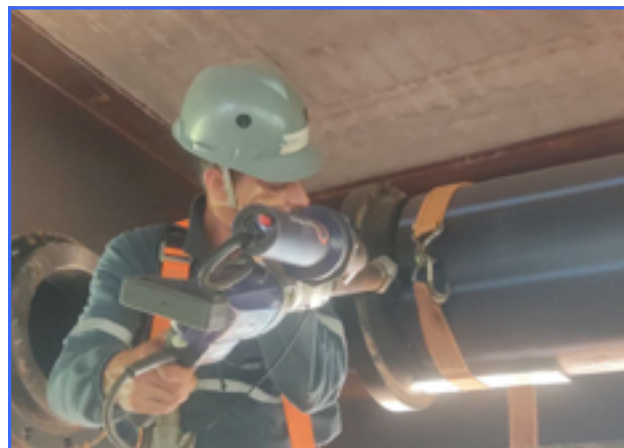
UNIÃO DOS TUBOS PEAD QUE COMPÕEM O SISTEMA DE DRENAGEM DA PONTE
