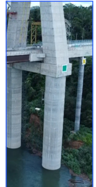
VISTA LATERAL LADO PARAGUAI - PLACAS SINALIZAÇÃO NÁUTICA INSTALADAS
