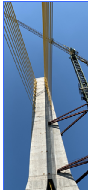
DESMOBILIZAÇÃO DAS ESCADAS DE ACESSO AO MASTRO BRASILEIRO (APOIO 06)
