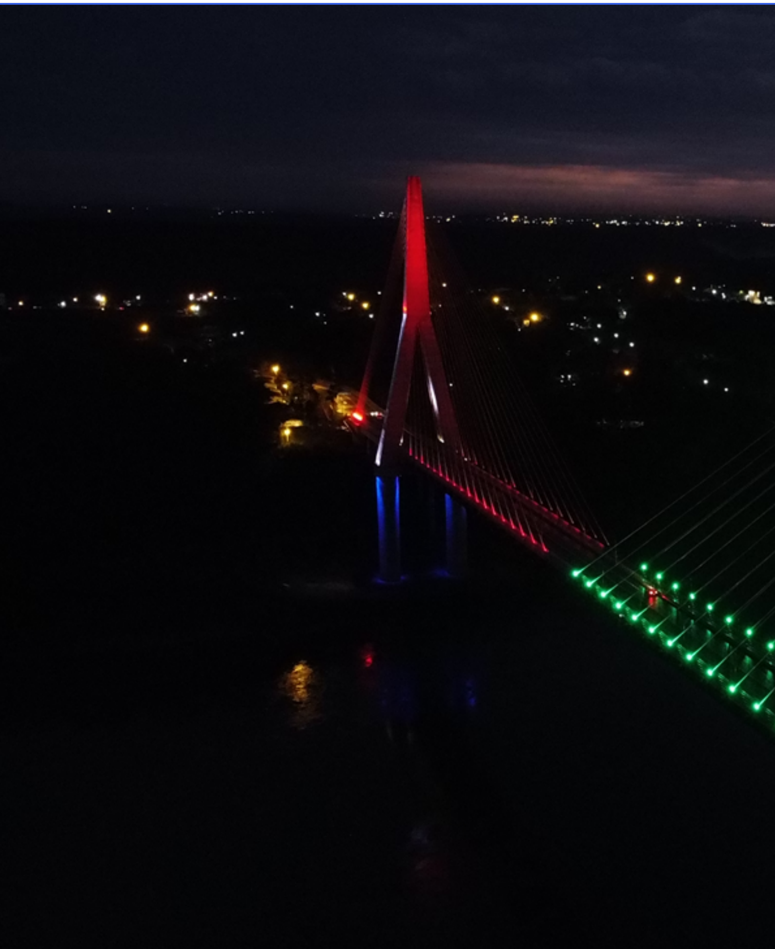
08: VISTA GERAL DA ILUMINAÇÃO CÊNICA DA PONTE DA INTEGRAÇÃO.
