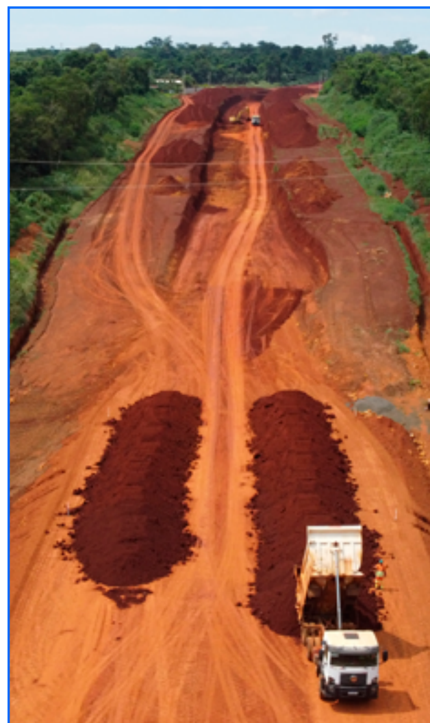
EXECUÇÃO DE SERVIÇOS DE TERRAPLENAGEM EM TRECHO DA LINHA GERAL
